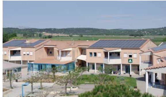
La location des toitures à Eneovia devrait rapporter près de 63 000 euros sur vingt ans au lycée.©Eneovia
